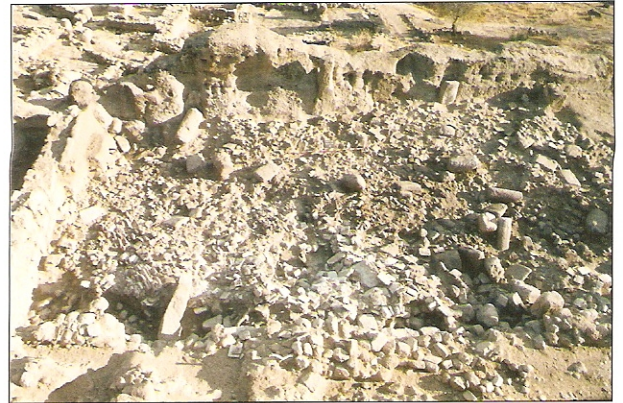
Figura 2 Derrumbes de arcos de ladrillo y pilares
