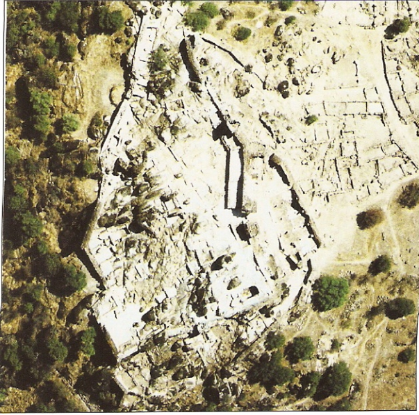
Figura 1 Vista aérea de la alcazaba de Vascos
